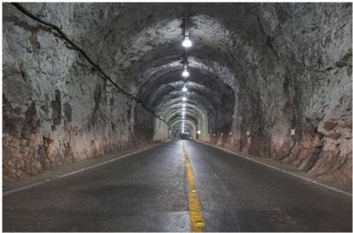
Mantenimiento de tuneles CFE Chiapas, Mexico
