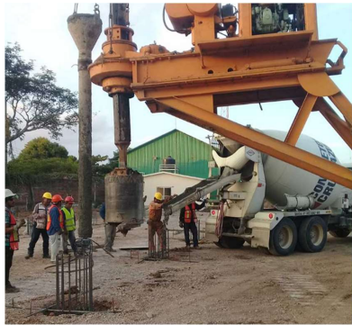
Cimentaciones profundas Pilotaje
