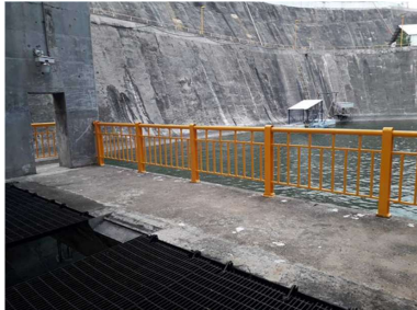
Vertedores de presa Chicoasen CFE
