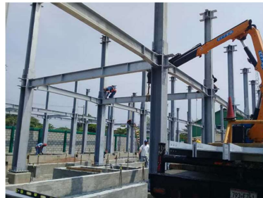
Edificio de oficinas CFE Estructura metálica Oaxaca, Mexico
