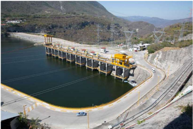
Proteccion de taludes Presa de Chicoasen
